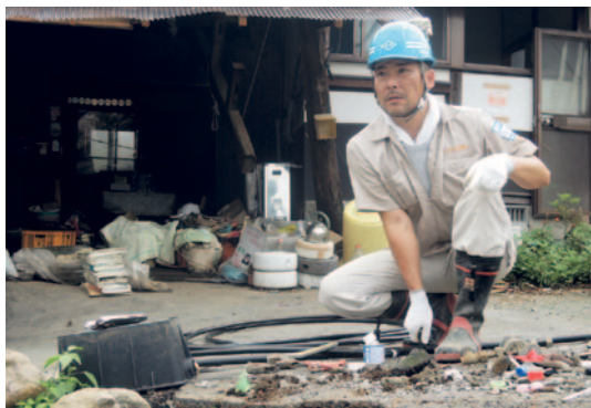
仮の水道管の復旧作業
