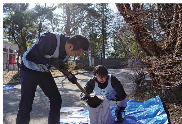
雨水排水桝清掃
