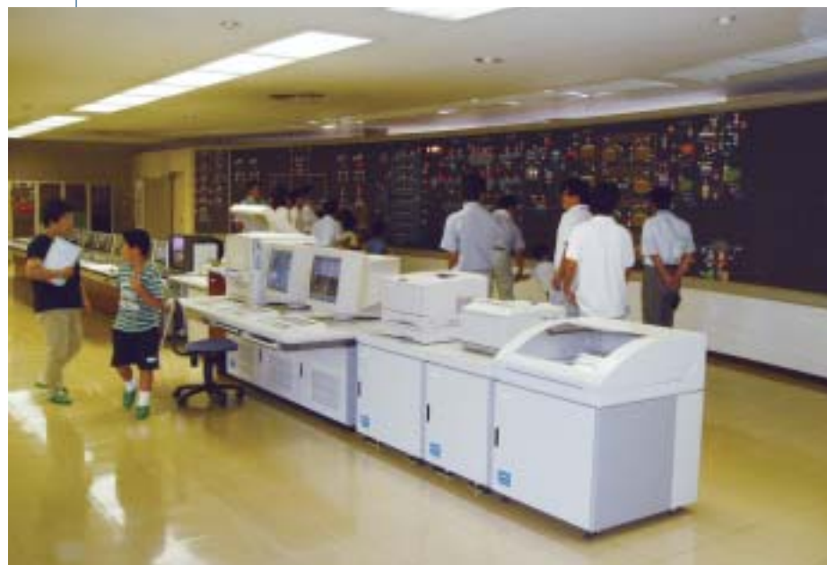
下水処理場制御盤室見学中
