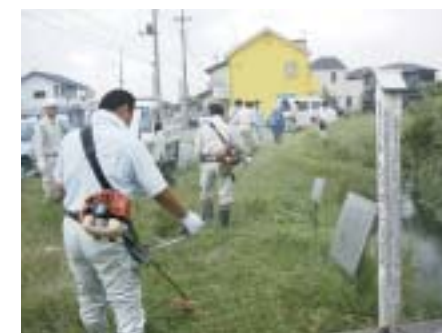
作業状況（猛暑の中での「元荒川」の法面での除草作業です）
